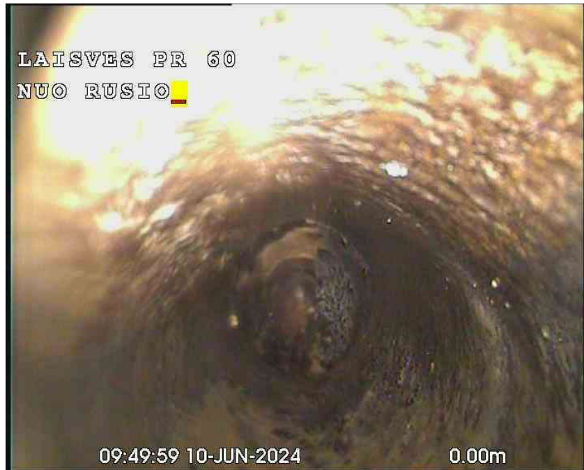
RusysŠulinys_8.jpg, 00:00:00, 0.00m Kanalo pradžia, šulinys
