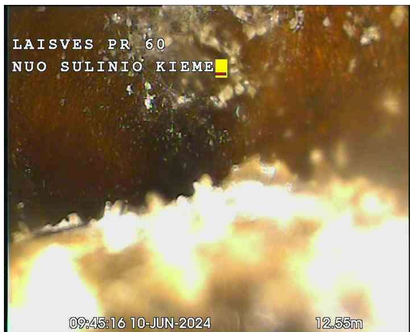
PastatasŠulinys kieme_7.jpg, , 12.55m Kamera stop. Kliūtis
